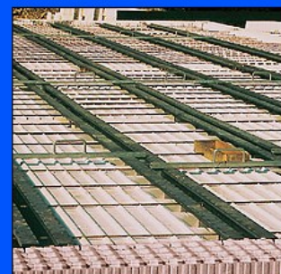
Decke vor der Betonfüllung
